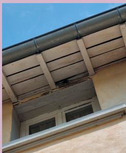
Espace entre les lattes de toitures pour martinets
