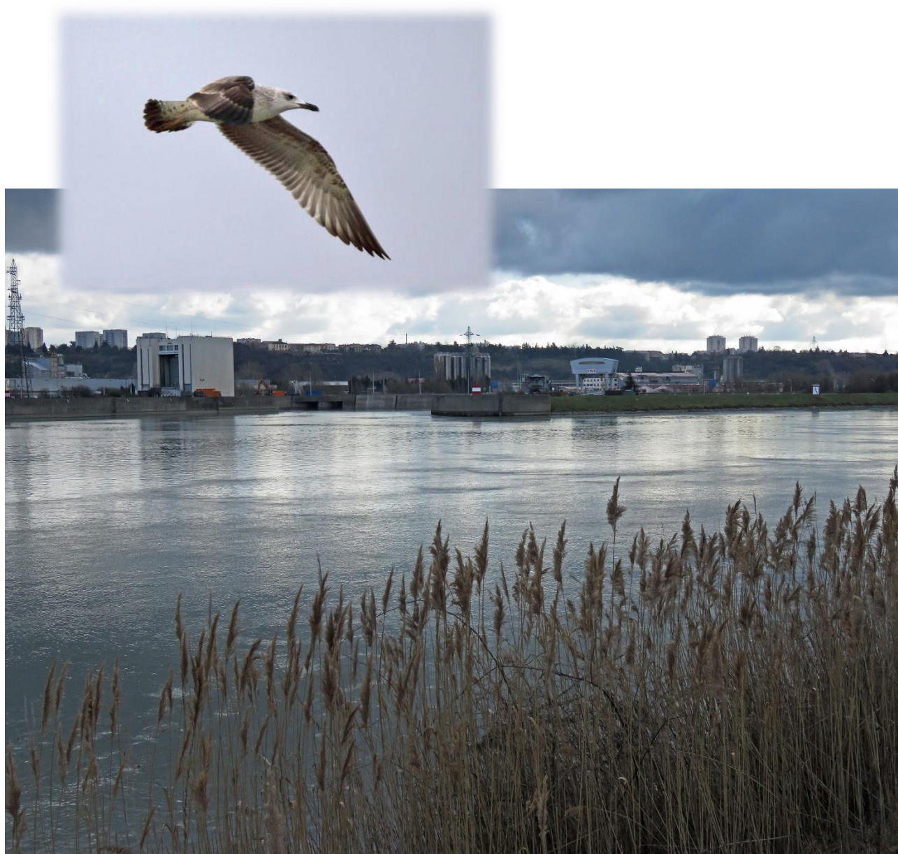
Ecluse et barrage de Pierre-Bénite, vue depuis la rive droite du fleuve, février 2018, D. TISSIER – en médaillon, Goéland pontique, écluse, 3 février 2018, L. LE COMTE.
