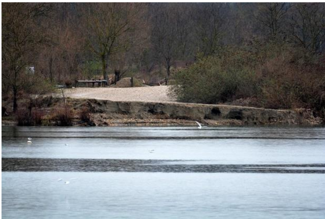
Digue emportée par la crue à Miribel-Jonage-, février 2018, Jean-Marie NICOLAS
