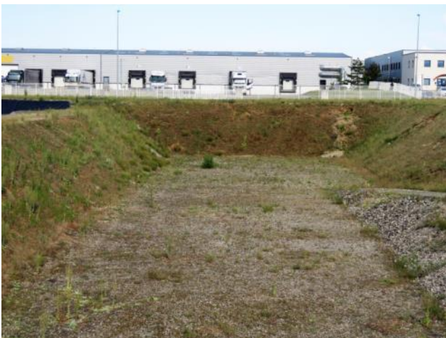
Photo n°11 : bassin de CargoPort, L. LE COMTE
