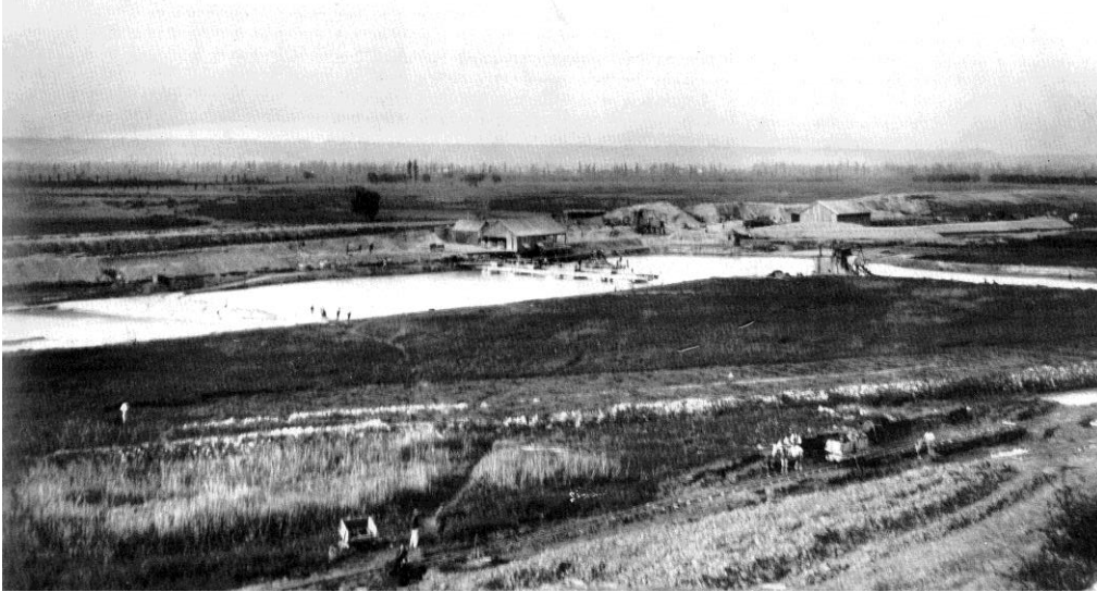
12 octobre 1895. Vue d'ensemble de l'écluse de garde de Jonage
