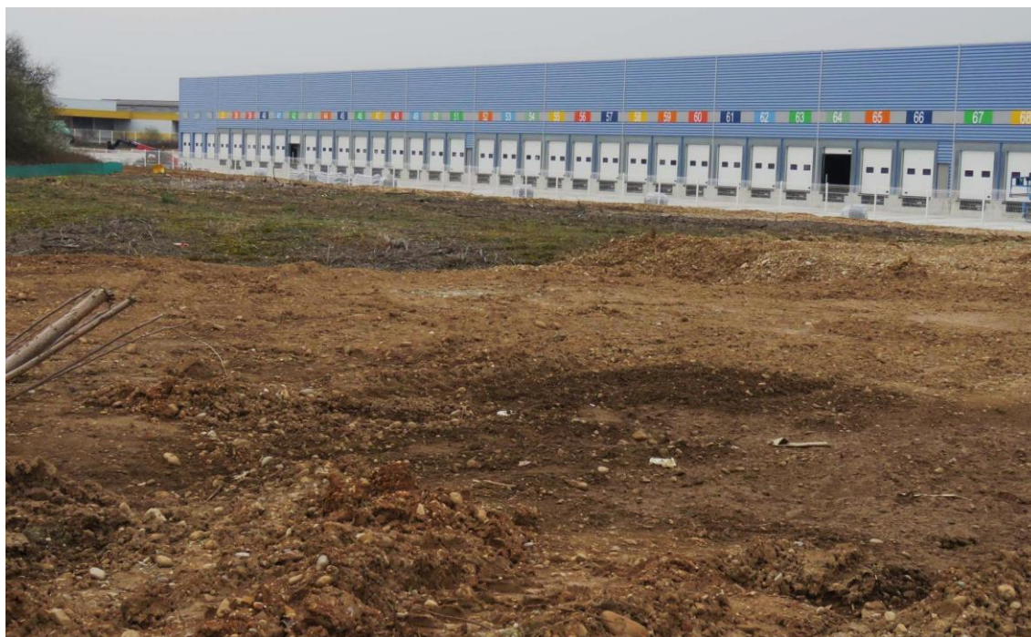
Grand bâtiment industriel construit durant l'hiver, sur le site de Genas Ratabizet-sud, qui abritait 2 couples en 2017. Il n'y a plus d'espace pour les oiseaux en 2018.
