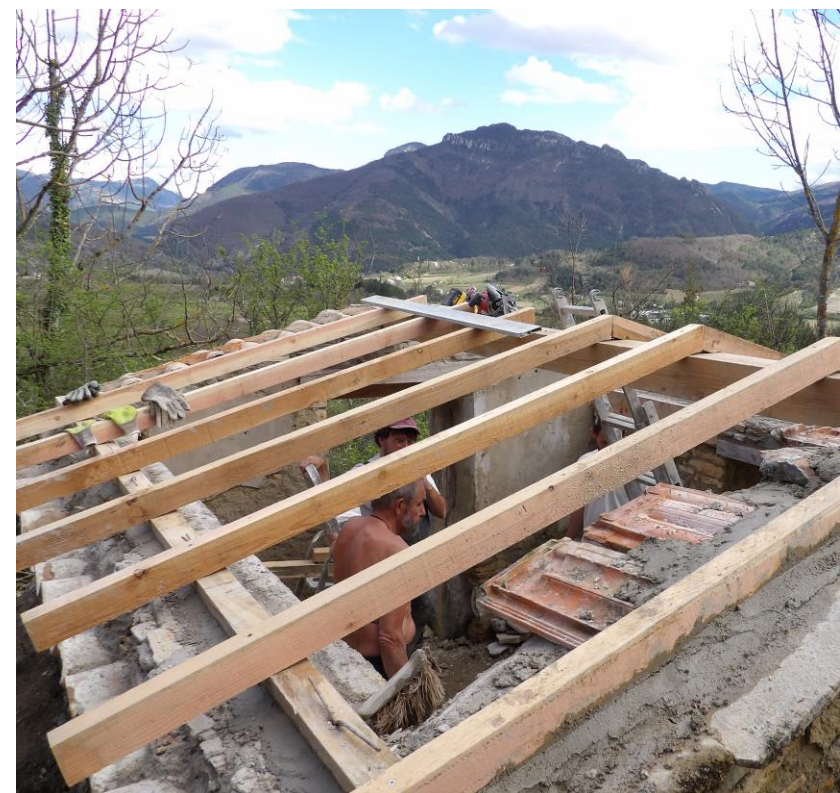
Reprise de la charpente ©Licia O.
