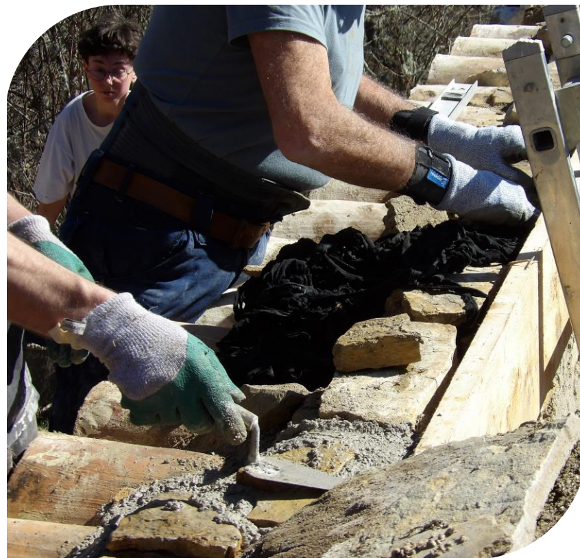
Reprise de la maçonnerie ©Licia O.
