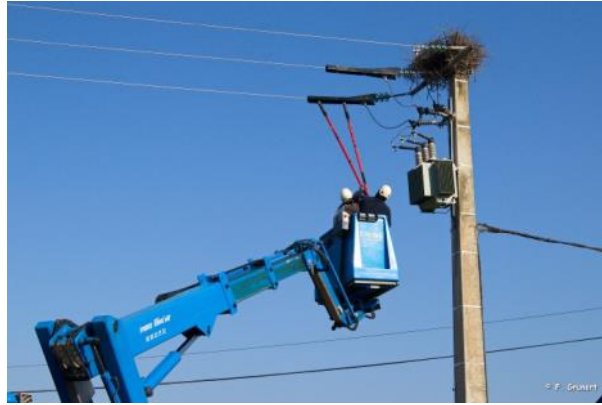
Mise en place des capots isolants
