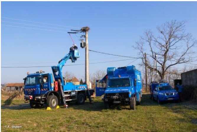
Mise en place des capots isolants
