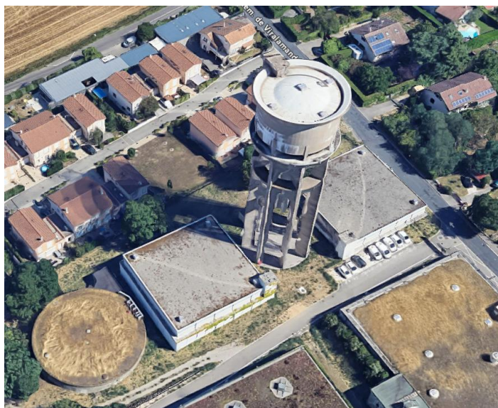
Photo n°14 : Château d'eau de Rillieux-la-Pape, source Google earth
